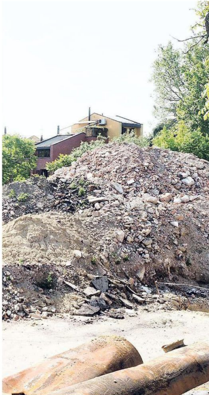
Il cantiere di via Libia dove sorgerà un nuovo supermercato
